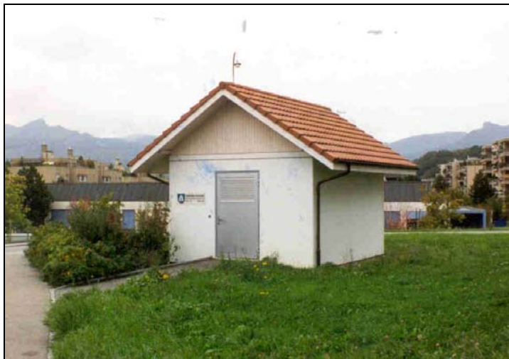
Das Pumpwerk beim Restaurant Wilerhof
