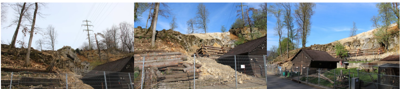
Der Wildpark Mühletäli - vor und nach dem Abtrag der absturzgefährdeten Felsnase
